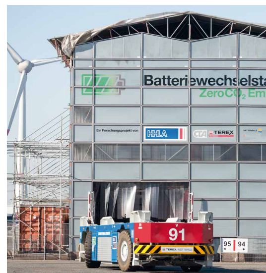
In der Batteriewechselstation sollen die Batterien der automatisierten Schwerlastfahrzeuge mit Ökostrom-Spitzen geladen werden
