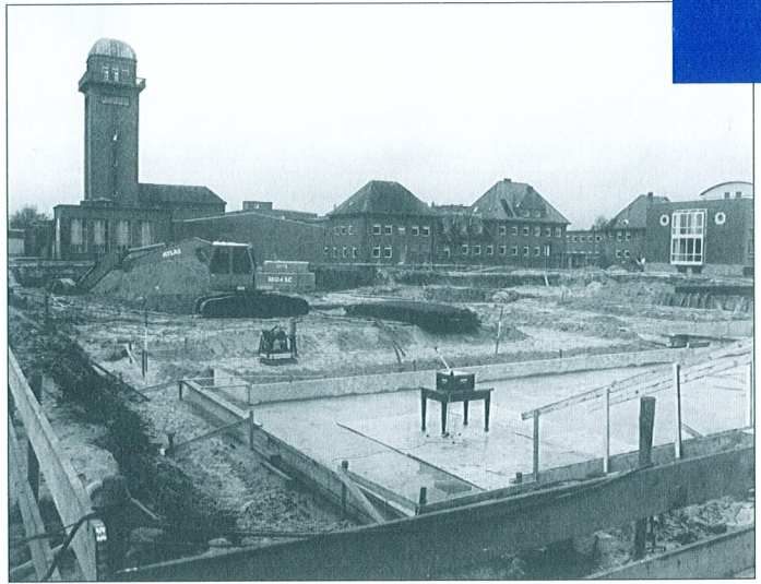
Baustelle: vor Grundsteinlegung
